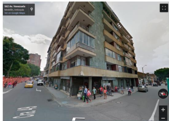
Fachada exterior del hogar #1
