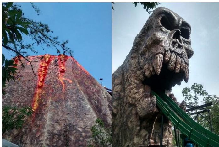
Figura 5. Renovación , de la atracción Viaje al Centro de la Tierra, Parque Norte de Medellín. Estructura en acero, cubierta en resina reforzada con fibra de vidrio. 2017
